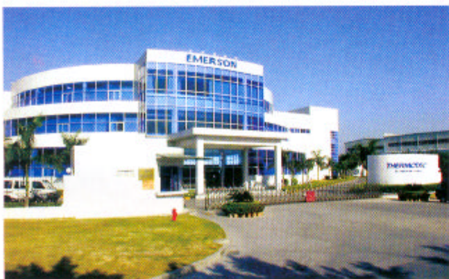
Emerson 在深圳建设的热敏碟生产厂。
