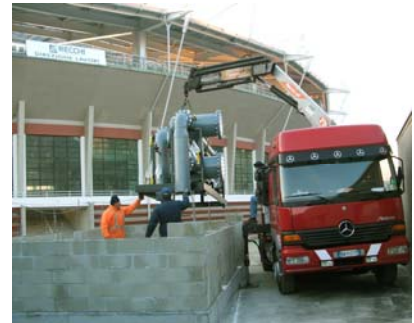
来自意大利博洛尼亚的 Emerson 工程师们，在位于都灵市区的新奥林匹克体育场中的主火炬内安装天然气调压系统。
